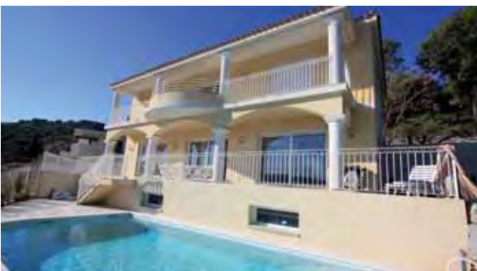
VILLA | 230m 2 | HAUTEURS / VALLAURIS | 1 520 000 €
